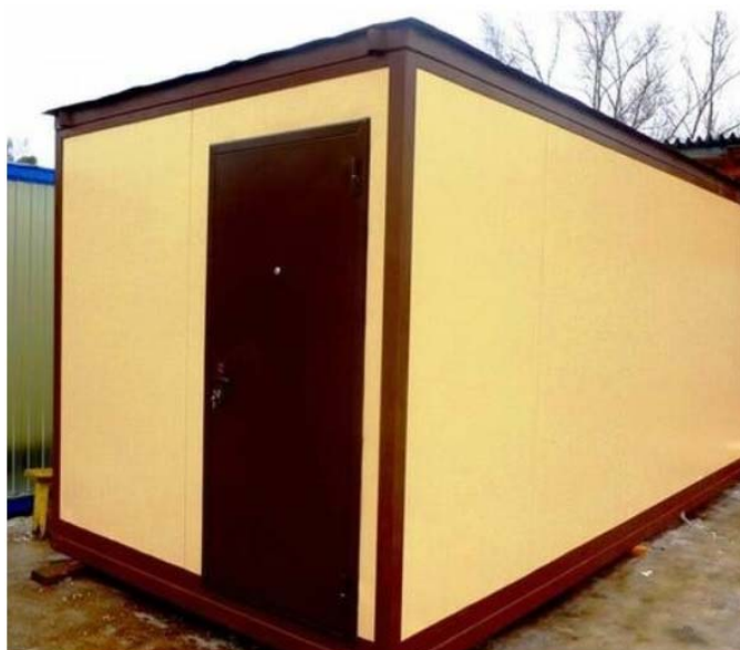
Рисунок 1 – Стандартная конструкция закрытого блок контейнера из сэндвич-панелей
